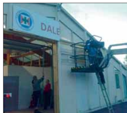
Dalborgarskiltið sett upp.
