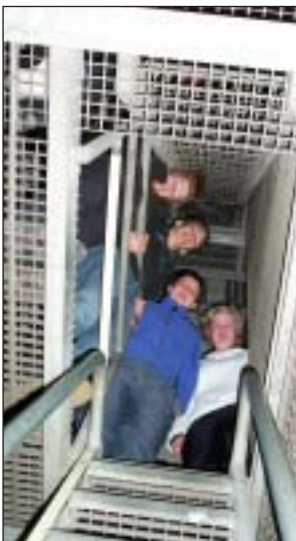
Horft niður í Blönduvirkjun.
